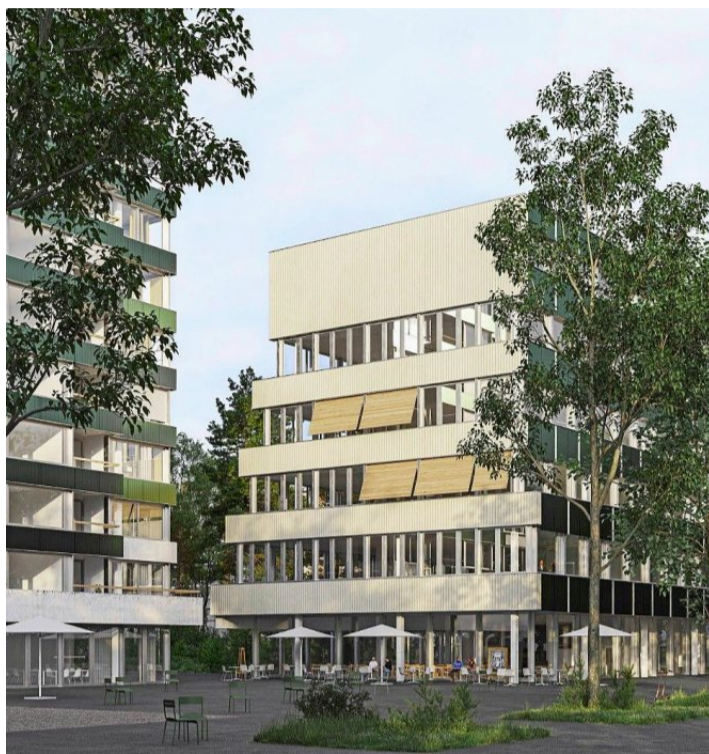
Der Gewerbebau (rechts) mit dem Restaurant im Erdgeschoss und das Wohnhochhaus werden in der ersten Bauetappe erstellt.
